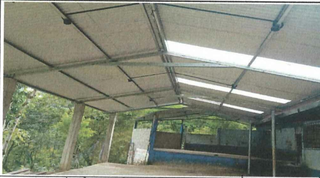
Foto 1: Instalación de energía eléctrica en Pasillo.
