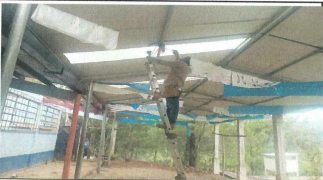
Foto 3: Instalación energía eléctrica.
