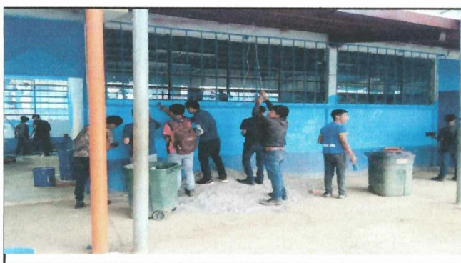
Foto 4: Mantenimiento de Pintura en Paredes.
