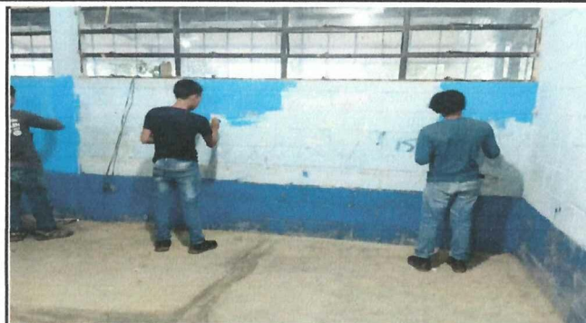
Foto 2: Mantenimiento de Pintura en Paredes.
