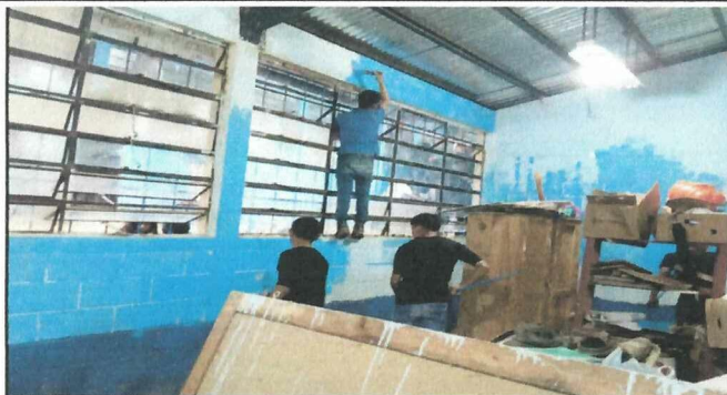
Foto 1: Mantenimiento de Pintura en Paredes
