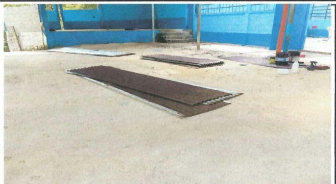
Foto 2: Instalación de laminas troqueladas.
