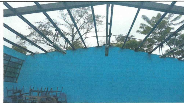
Foto 4: Instalación de entechado
