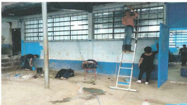
Foto 3: Mantenimiento de Pintura en Paredes.
