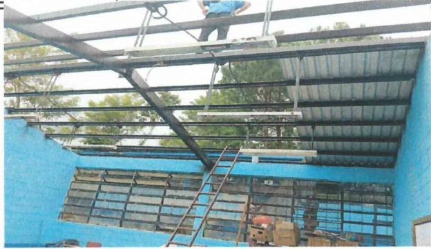
Foto 1: Mantenimientos de entechado de Aulas.
