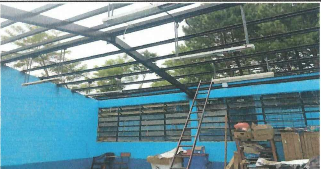
Foto 5: Instalación de entechado.
