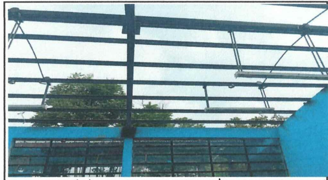
Foto 4: Instalación de entechado
