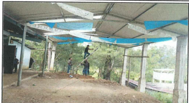
Foto 2: Instalación energía eléctrica.
